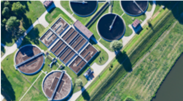
水和污水处理
